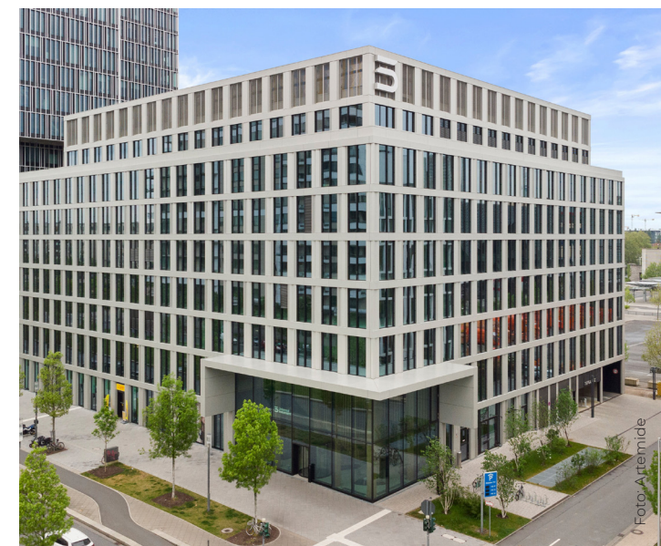
Der Timber Pioneer von Eike Becker ist im aufstrebenden Europaviertel Frankfurts das erste Bürogebäude in Holz-Hybrid-Bauweise.
